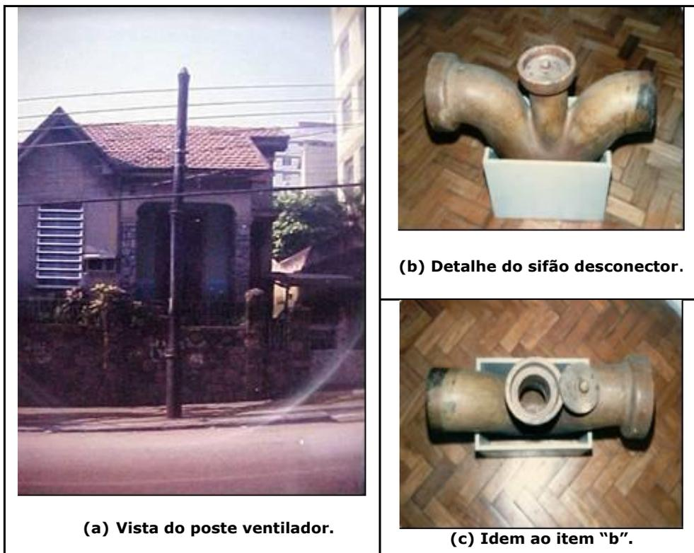
**Figuras 19. Elementos de controle de gases em rede coletora de esgoto sanitário.**
