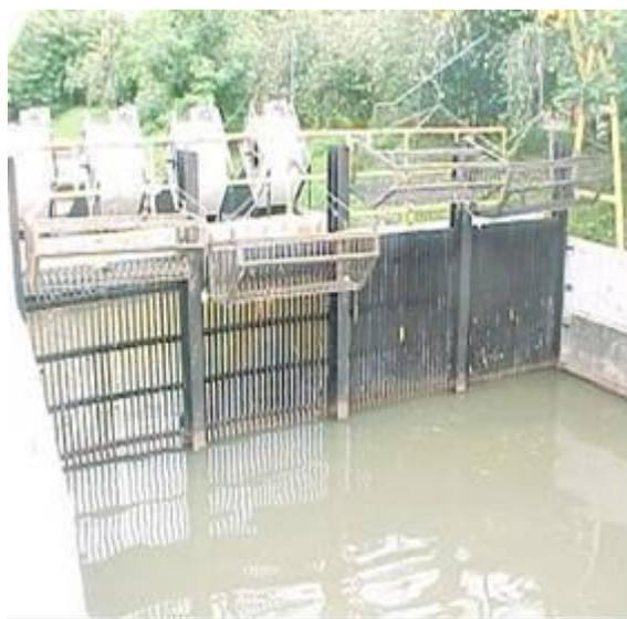
**Figuras 17. a) Canal de entrada da Estação de Despoluição do rio Carioca; b) Sistema de gradeamento para retirada de material grosseiro.**
