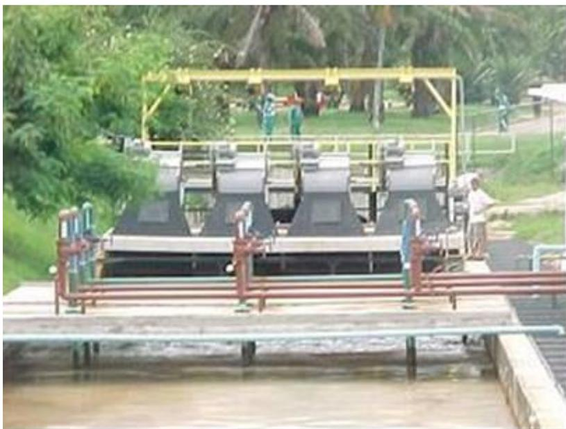
**Figura 18. Sistema de injeção de ar e lançamento de polímero.**
