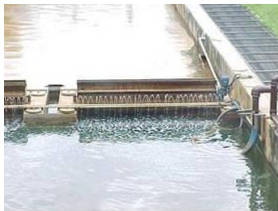
**Figuras 19a e 19b. Vistas do ponto de lançamento de cloro na Estação de Despoluição do rio carioca.**
